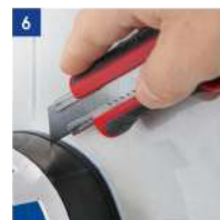
Odcięcie nadmiaru obudowy
