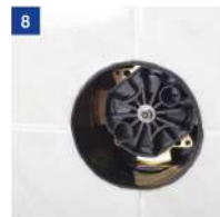
Demontaż modułu do przeplukania instalacji
