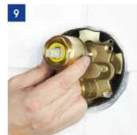
Montaż elementu funkcyjnego
