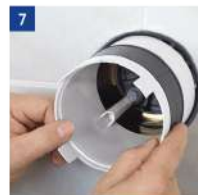
Wyciągnięcie elementu usztywniającego obudowę
