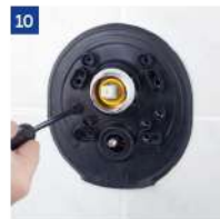
Montaż elementów zewnętrznych
