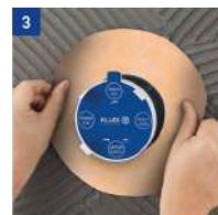
Położenie tynku i naklejenie kalnierza uszczelniającego
