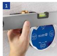
Zamocowanie elementu podtynkowego
